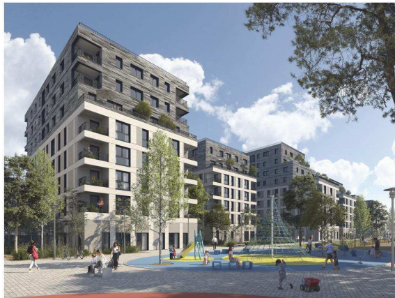
Figure 350 : Vue sud du bâtiments du lot 4.1
