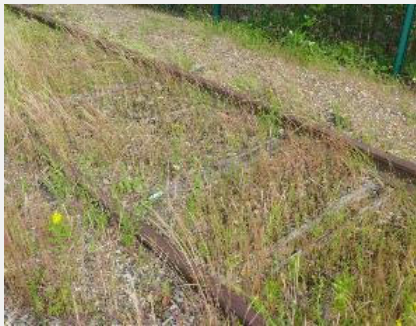
Figure 401 : fasciés favorable à reconstituer – voie ferrée existante (Confluences)
