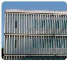
Des lamelles verticales ou horizontales produisant une ombre et divisant la façade. Les oiseaux voient qu'il s'agit d'un obstacle.
