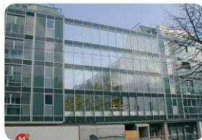
Paroi antibruit et coupe-vent entre deux bâtiments
