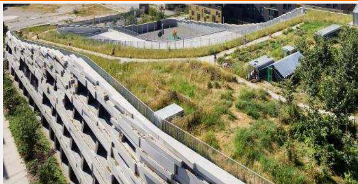
Exemple de toitures végétalisées fonctionnelles (Ecole Boulogne Billancourt-architecte Sophie DERAMOND)
