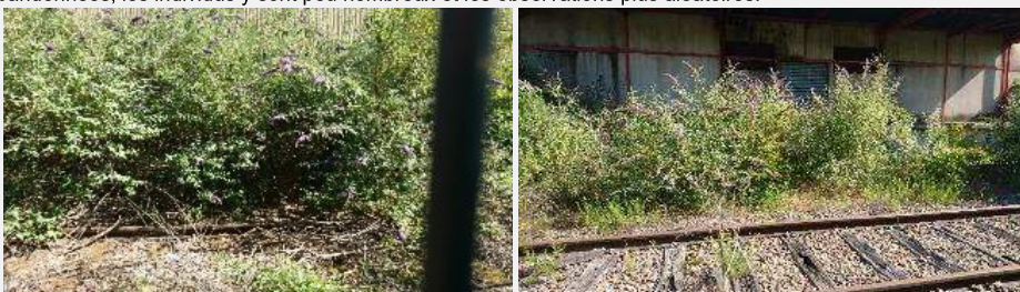
Voies ferrées relictuelles existantes avec de nombreux Buddléia
