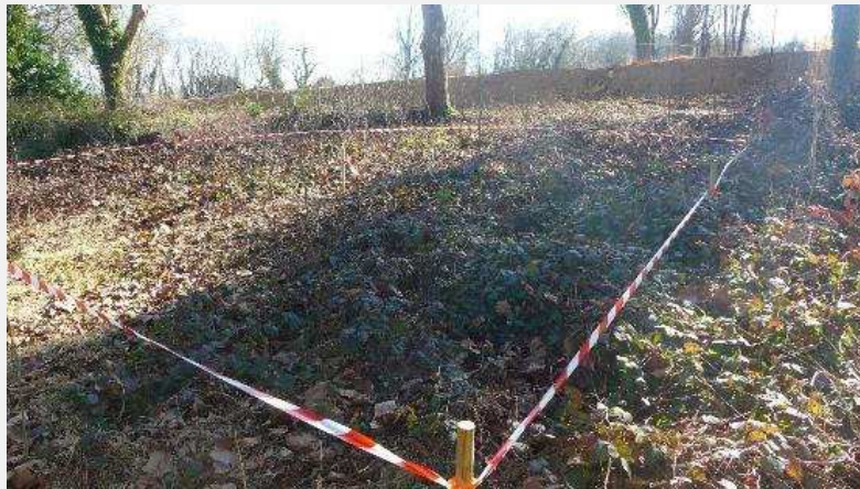
Figure 382 : Exemple de rubalise dans un chantier
