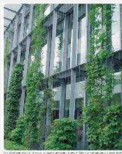
Une façade végétalisée permet de réduire la réflexion et d'atténuer la chaleur. Elle est aussi un piège à insectes.
