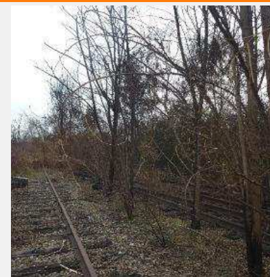
Figure 400 : Fourrée arboré avant restauration
